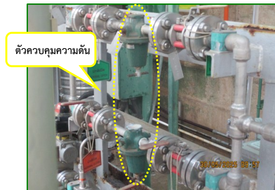
ภาพที่ 2.40 การติดตั้งระบบป้องกันและควบคุม ความดันของถังแอมโมเนีย
