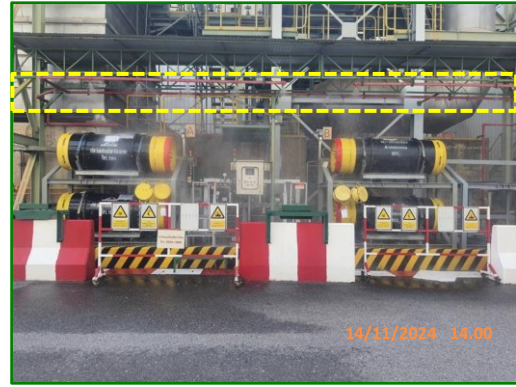
ภาพที่ 2.38 ระบบสเปรย์น้ำบริเวณถัง แอมโมเนีย
